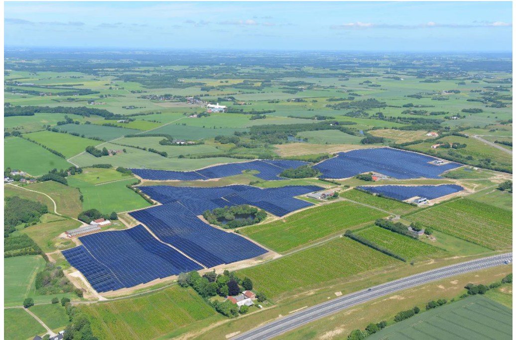
Feriflächensolaranlage Silkeborg Quelle: Arcon-Sunmark A/S
