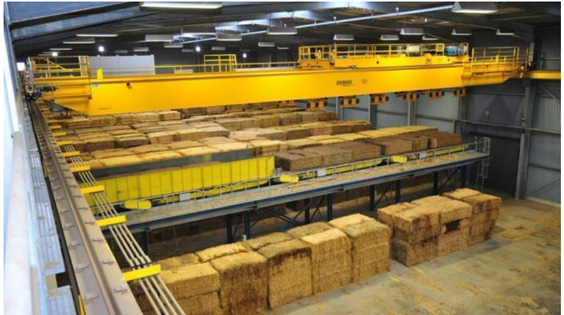
Brennstofflager mit Stroh-Großballen Quelle: HKW Emlichheim
